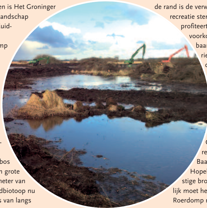
Werkzaamheden Zuidlaardermeer (foto's: Michel Krol)
