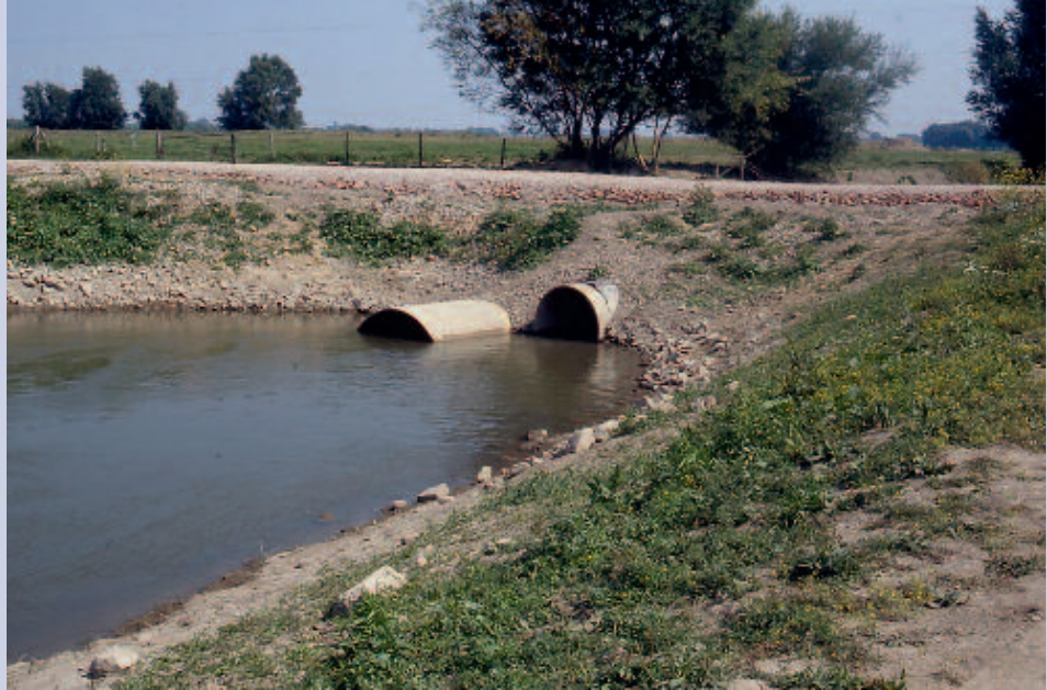
Foto 5. Tijdens normale waterstanden op de Waal bepalen deze duikers het debiet door de nevengeul (foto: Alexander Klink).
