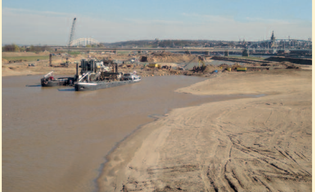
Foto 3. De aanleg van een nieuwe nevengeul, een stadseiland en een dijkverlegging bij Nijmegen, gekoppeld aan stadsontwikkeling op de noordoever van de Waal (foto: Bart Peters).
